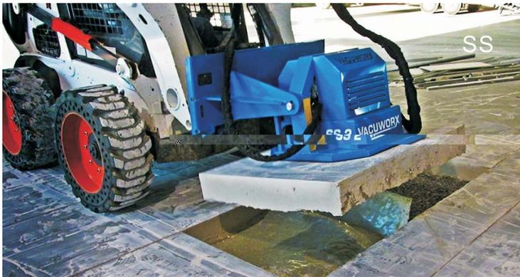
SS系列是專門設計搭配如堆土機的運用，適用於工程石塊板鋪路、庭園造景工程，可快速安全的將搬運套件固定於堆土機上，並由駕駛者透過控制線控制被吸取物件的吸放動作，是省力、無人化的極緻表現。
