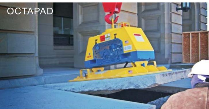
OCTAPAD系列真空搬運系統設計用於道路和橋樑施工中的混凝土板移除，8個平墊中，每一個都有一個獨立的真空供應，可以關閉那些因損壞而不能升降的板塊移動，並與挖土機或吊車配合使用。
